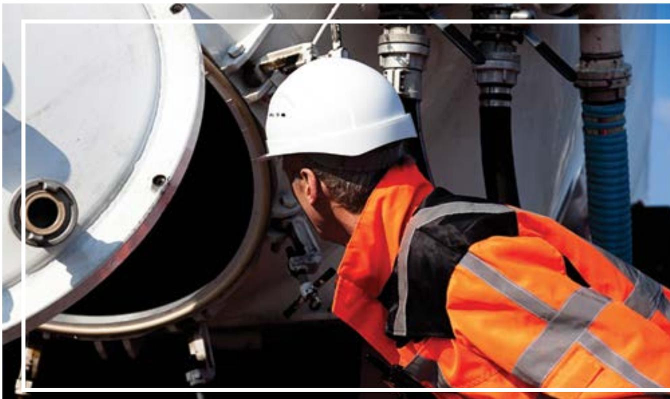
Alors que le stockage de substances dangereuses comporte des risques pour l'environnement et la population, il est primordial d'effectuer des contrôles réguliers des réservoirs pour éviter toute fuite. Les intempéries et les variations de température peuvent, en effet, fragiliser les cuves de stockage et entraîner une contamination des sols et cours d'eau.
